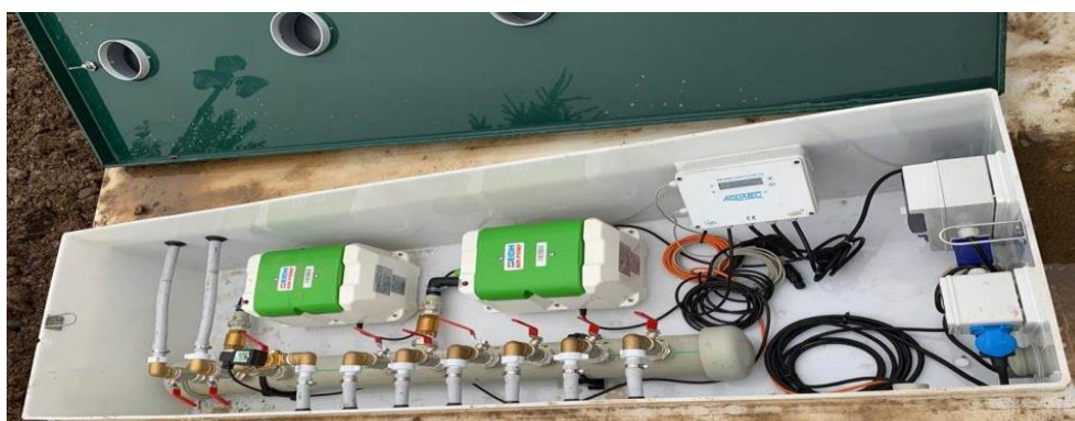
ci-dessous : centrale de commande et régulation intégrée
