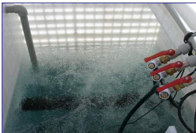
Station d'épuration autonome avec recyclage des eaux traitées en eaux de process industriel - Abattoir de volailles , Pacy sur Eure (27)
