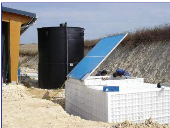
Station d'épuration autonome avec recyclage des eaux traitées en eaux de process industriel - Abattoir de volailles , Pacy sur Eure (27)
